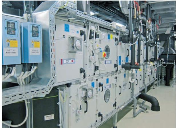
Alle äusseren Wandplatten bestehen aus verzinktem Stahlblech, wobei alle Verbindungsstücke zwischen Rahmen und Wänden mit Kitt für Reinraumanwendungen abgedichtet sind.
