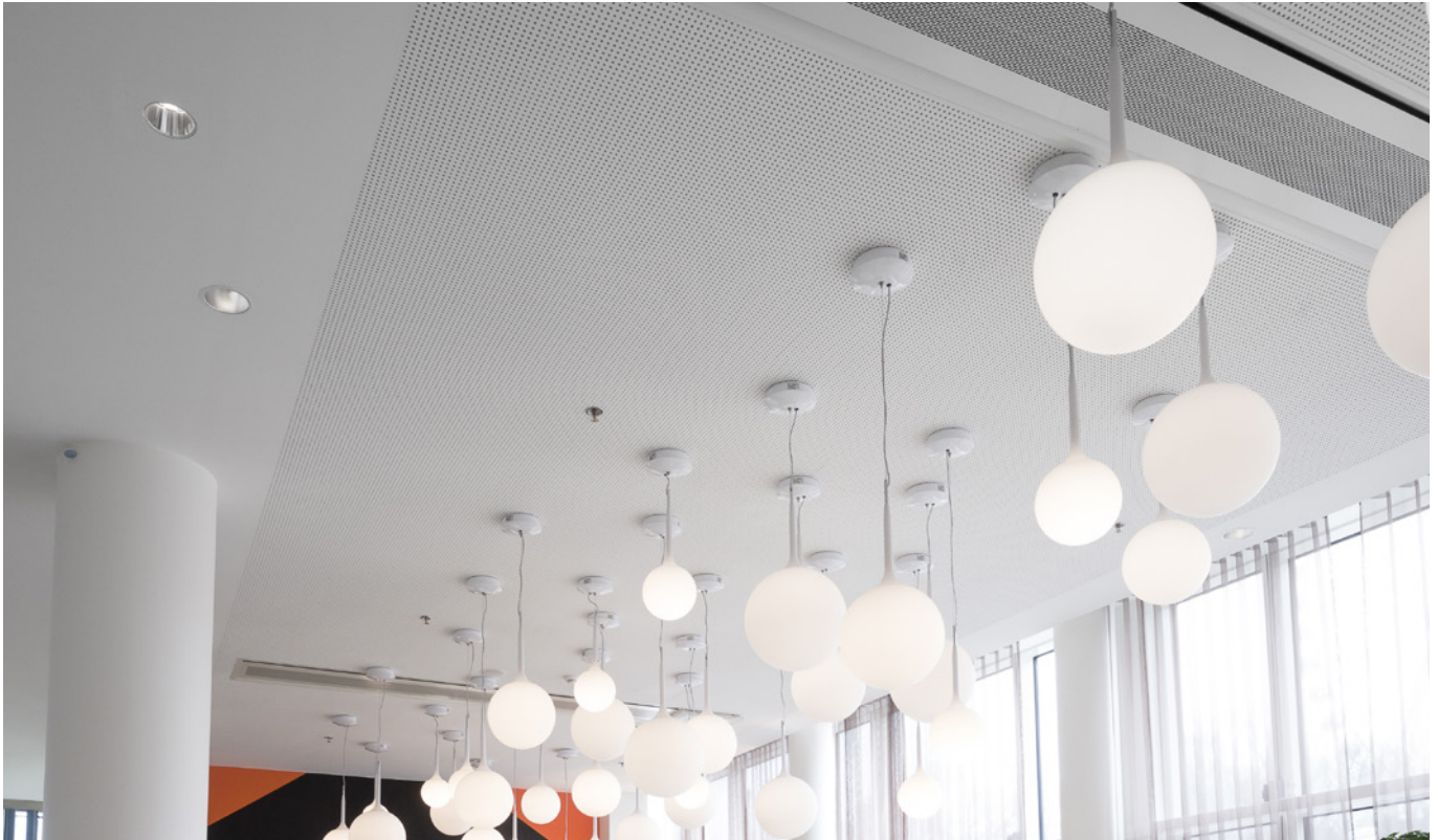
Bild 1. Aktiver Kühlbalken Professor XP integriert in einer abgehängten Decke.
